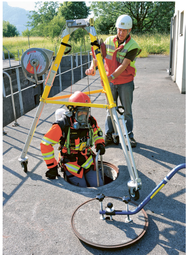
21 Einstieg in einen Schacht über eine Leiter. Sicherung durch Auffanggurt und Höhensicherungsgerät mit Rettungskurbel. Der Eingestiegene kann jederzeit von aussen mit der Rettungskurbel hochgezogen werden.
