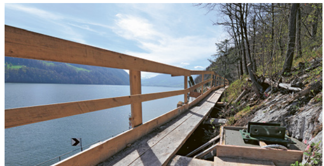
30 Bei umfangreichen Arbeiten im Gelände (z. B. Felssicherung) müssen die Zugänge zu den Arbeitsplätzen sicher gestaltet werden. Der Seitenschutz ist den Gegebenheiten angepasst zu erstellen (gemäss Bauarbeitenverordnung [BauAV] Art. 15 und 16).
