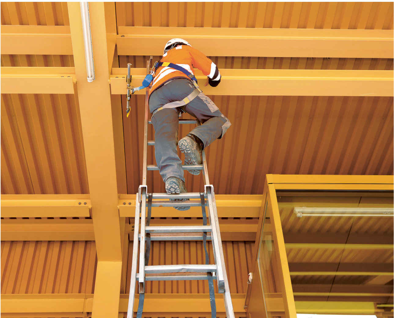
27 Gesichertes Arbeiten auf einer Leiter mit Höhensicherungsgerät und mobilem Anschlagpunkt.
