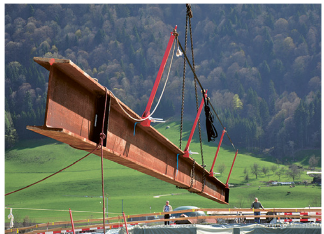
26 Gut geplant: Ein Stahlträger wird mit dem bereits vormontierten Lifeline-System auf der Baustelle eingehoben.
