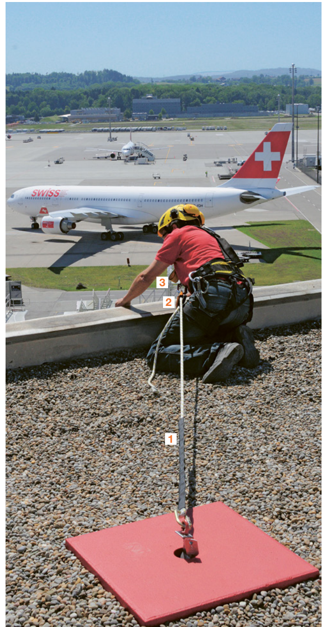
13 Auf einem Dach arbeitende Personen, die durch Auffanggurten an einem Sicherungsseil gesichert sind. Die Länge des Sicherungsseiles lässt sich mit einem festklemmenden Seilkürzer einstellen. Er ist so eingestellt, dass die gesicherte Person den Dachrand gerade noch erreichen kann.
