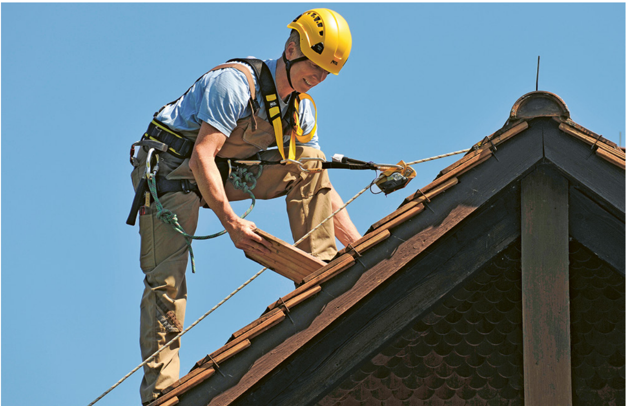
9 Reparaturarbeiten auf einem Dach, Sicherung mit Auffanggurt und Sicherungsseil. Die Seillänge zum Anschlagpunkt kann mit einem einstellbaren Verbindungsmittel oder einem feststellbaren, mitlaufenden Auffanggerät auf dem Sicherungsseil eingestellt werden.
