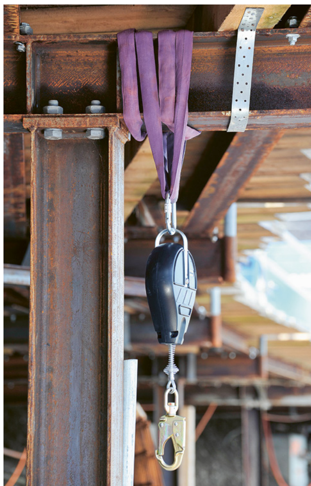
23 Fixation d'une corde d'assurance à un élément porteur présentant une résistance suffisante.
