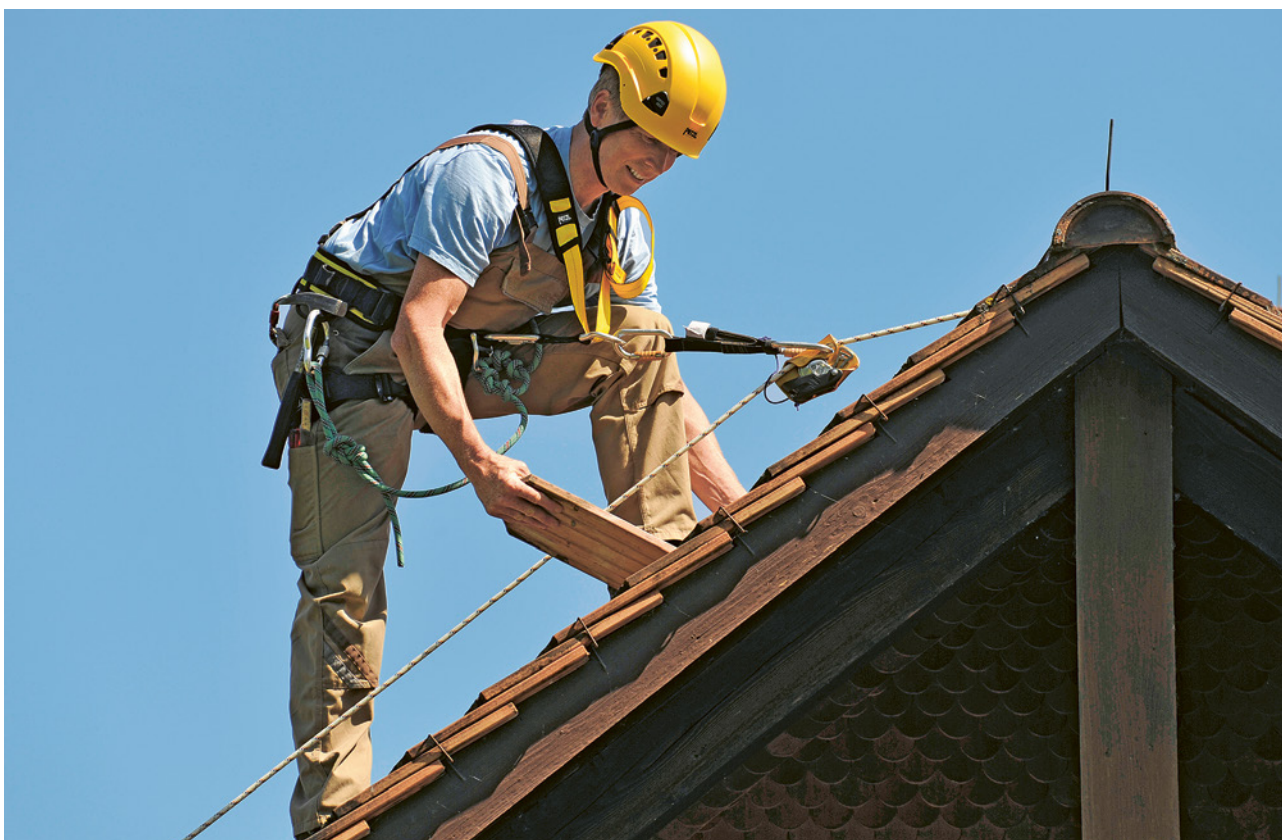
9 Travaux de réfection sur un toit: protection par harnais de protection contre les chutes et corde d'assurage. Le positionnement s'effectue grâce à un élément de réglage de la longueur de la corde ou à un antichute mobile.
