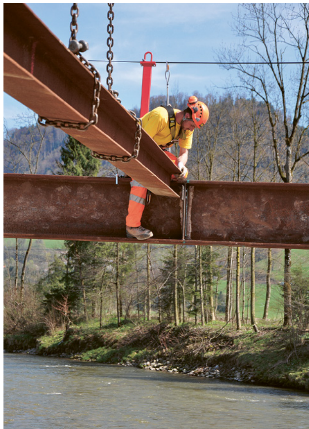
25 Montage d'une construction métallique avec assurage sur une ligne de vie horizontale.
