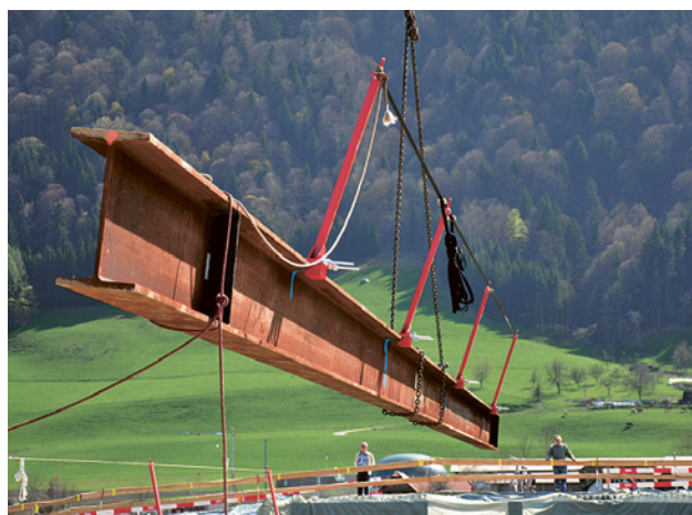
26 Bonne planification: une poutre est transportée sur le chantier avec la ligne de vie préalablement montée.
