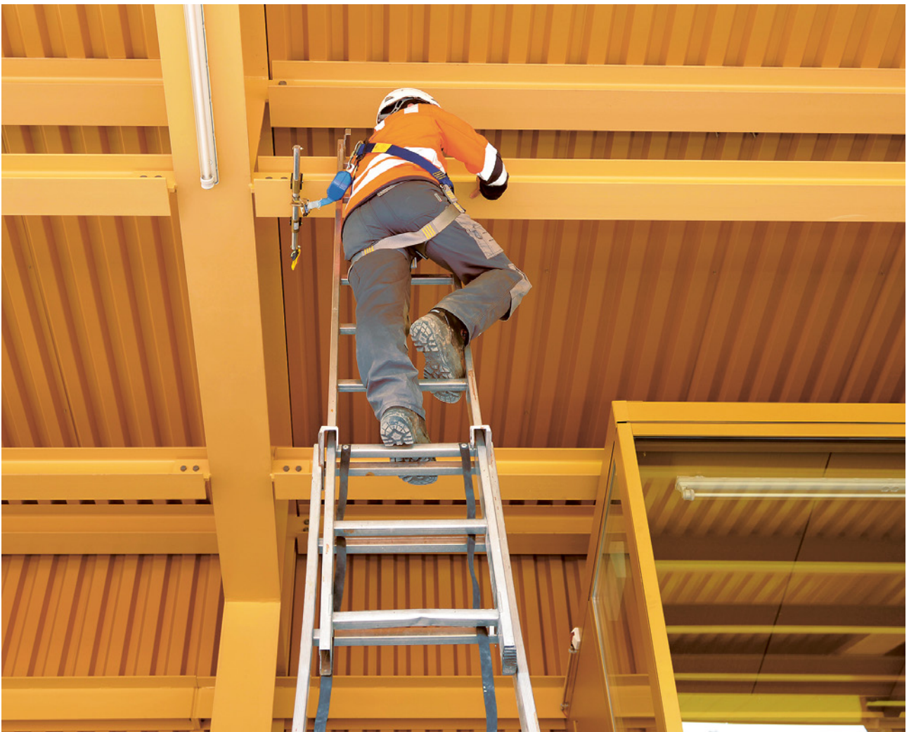
27 Travaux sécurisés sur une échelle avec antichute à rappel automatique et ancrage mobile.
