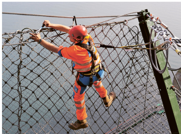
8 Assurage avec harnais de protection contre les chutes et corde de retenue. La corde de retenue est munie d'un gros mousqueton pour l'accrochage au point d'ancrage.
