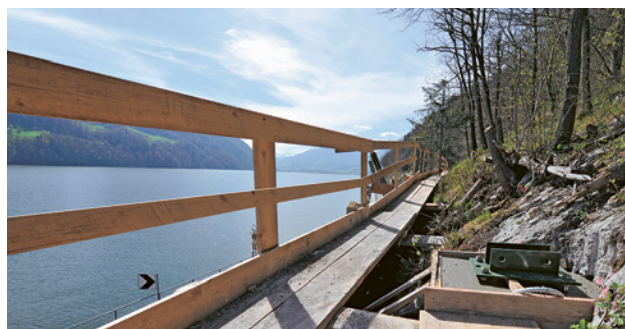
30 Lors de travaux de grande ampleur (p. ex. sécurisation de roche), les accès aux emplacements de travail doivent être sûrs. Le garde-corps périphérique doit être adapté aux circonstances (conformément aux art. 15 et 16 OTConst).
