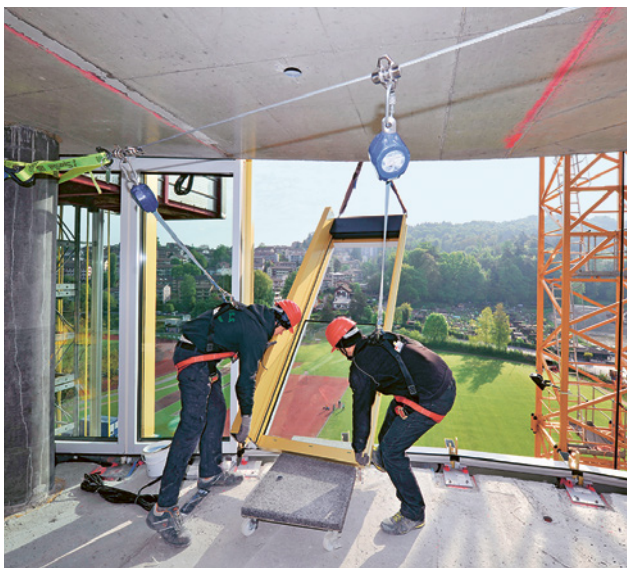
24 Travaux sur le bord d'un toit.
