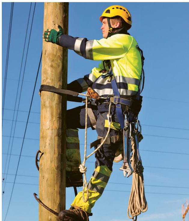
6 Poseur de lignes aériennes gravissant un poteau en bois à l'aide de crampons et d'une ceinture de maintien.
